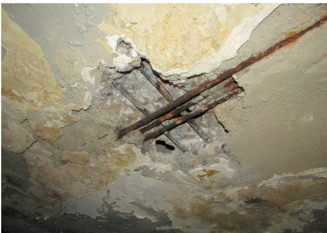
Figura 2-28 Cata P3-2. Acero con pérdida de corruga y pérdida de sección.
