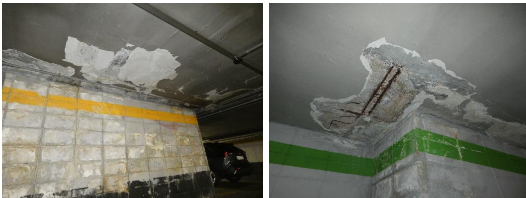
Figura 1-10. Humedad en la escalera al sótano -2 (izquierda) y refuerzo descubierto cerca de la escalera al sótano -3 (derecha)
