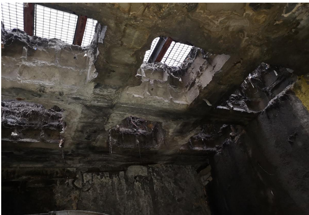
Figura 1-10 Detalle estampidores dañados.
