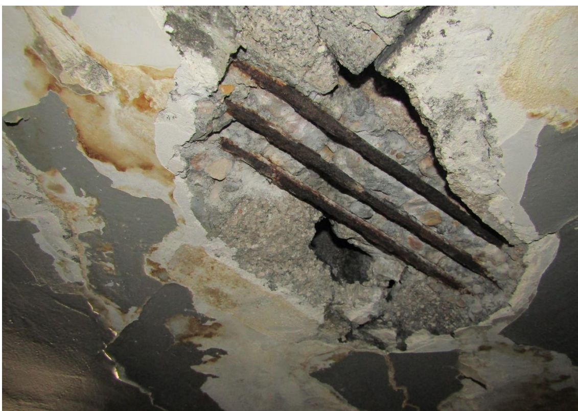
Figura 2-32 Cata P3-6. Acero con pérdida de corruga y pérdida de sección.
