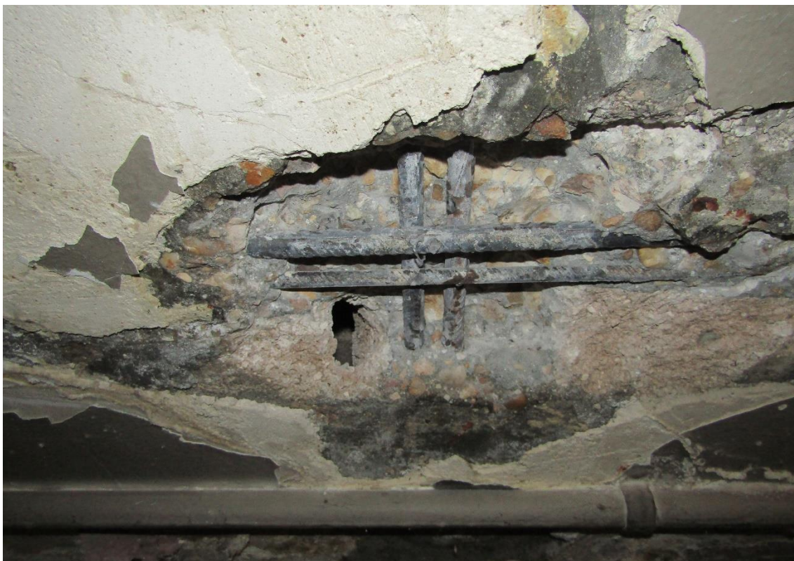
Figura 2-22 Cata P2-7. Acero sin pérdida de corruga. Signos de humedad en el hormigón alrededor de la cata.
