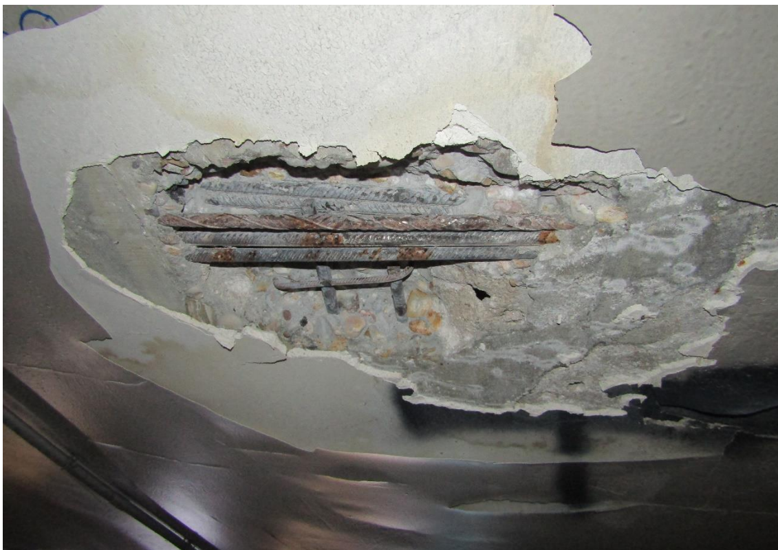
Figura 2-33 Cata P3-7. Acero sin pérdida de corruga. Signos de humedad en el hormigón alrededor de la cata.
