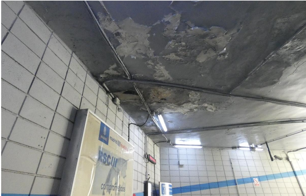
Figura 1-1 Ejemplo paño de forjado de sótano -1 con alto nivel de humedad percibida.
