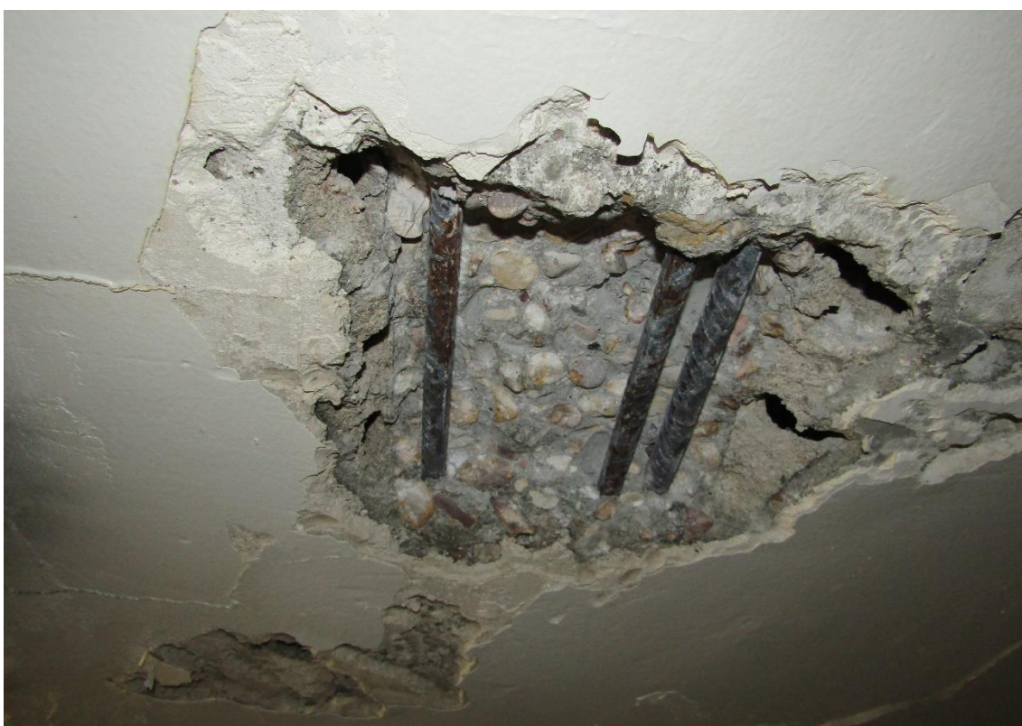
Figura 2-47 Cata P4-9. Acero con pérdida de corruga puntual.
