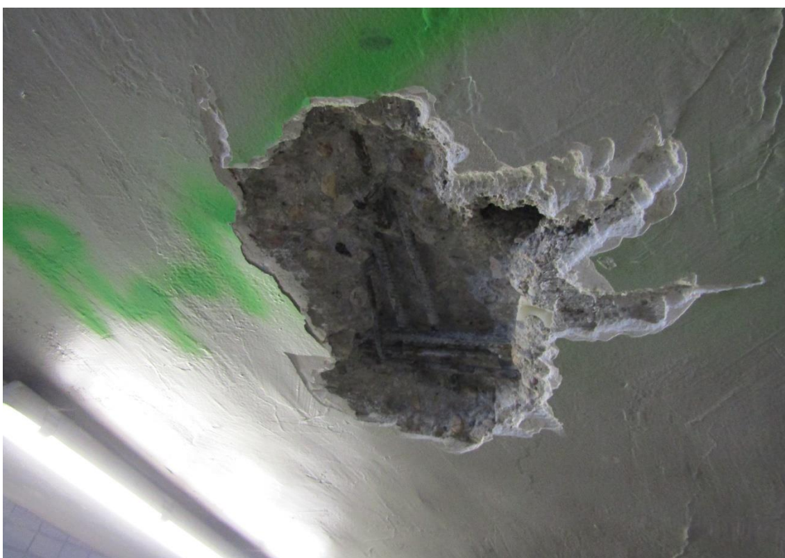
Figura 2-39 Cata P4-1'. Acero sin pérdida de corruga. Signos de humedad en el hormigón alrededor de la cata.
