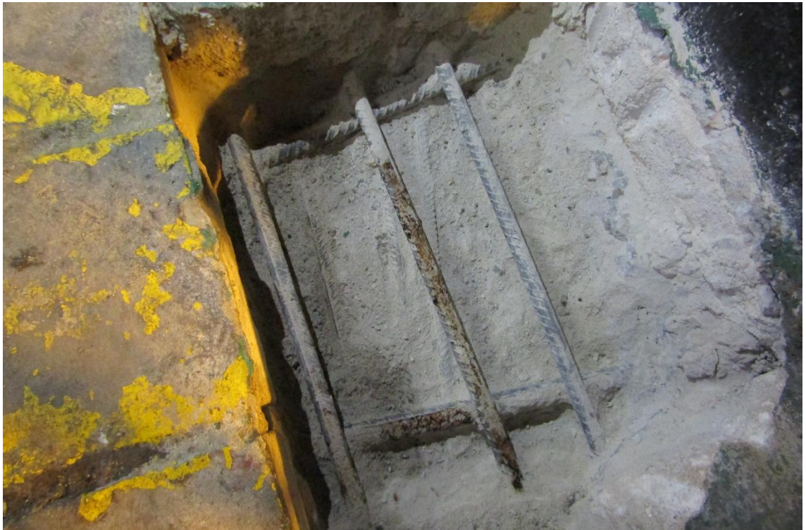
Figura 2-50 Cata P2-1, ejecutada en la cara superior del techo del sótano -2. No signos de corrosión evidente.
