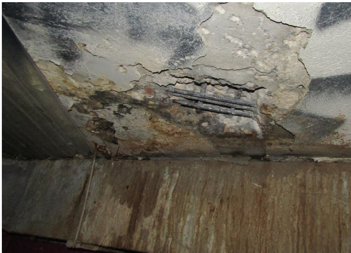
Figura 2-48 Cata P4-10. Acero sin pérdida de corruga. Signos de humedad en el hormigón alrededor de la cata.
