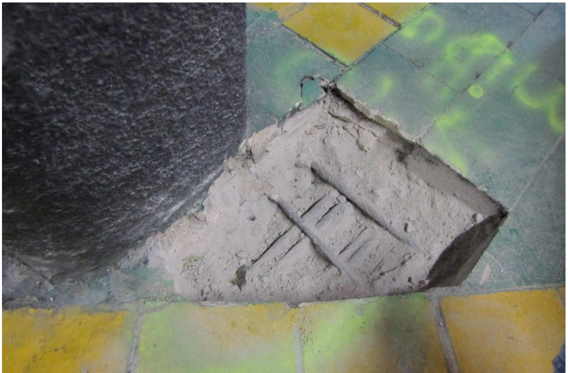
Figura 2-51 Cata P3-10, ejecutada en la cara superior del techo del sótano -3. No signos de corrosión evidente.
