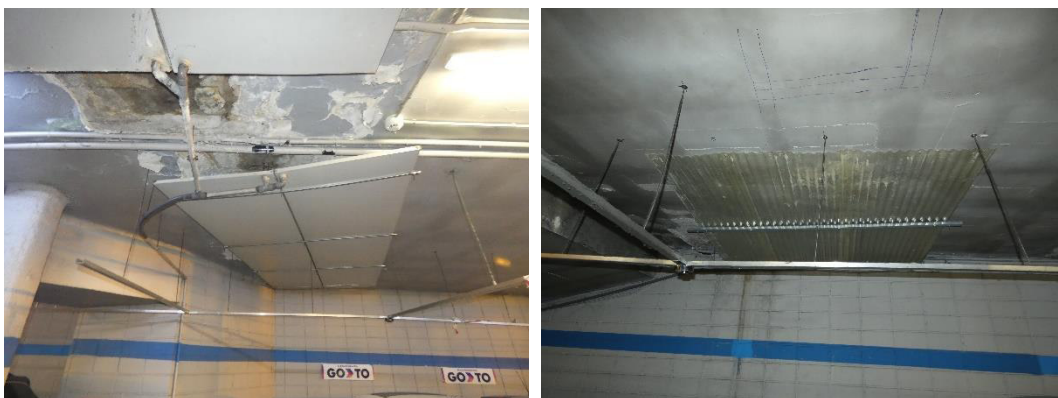
Figura 1-12. Paneles de protección para los coches
