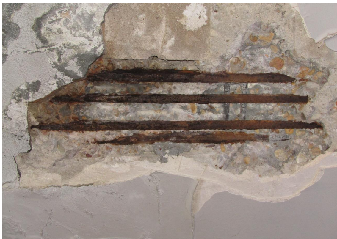
Figura 2-13 Cata P1-12. Acero con pérdida de corruga y pérdida de sección.
