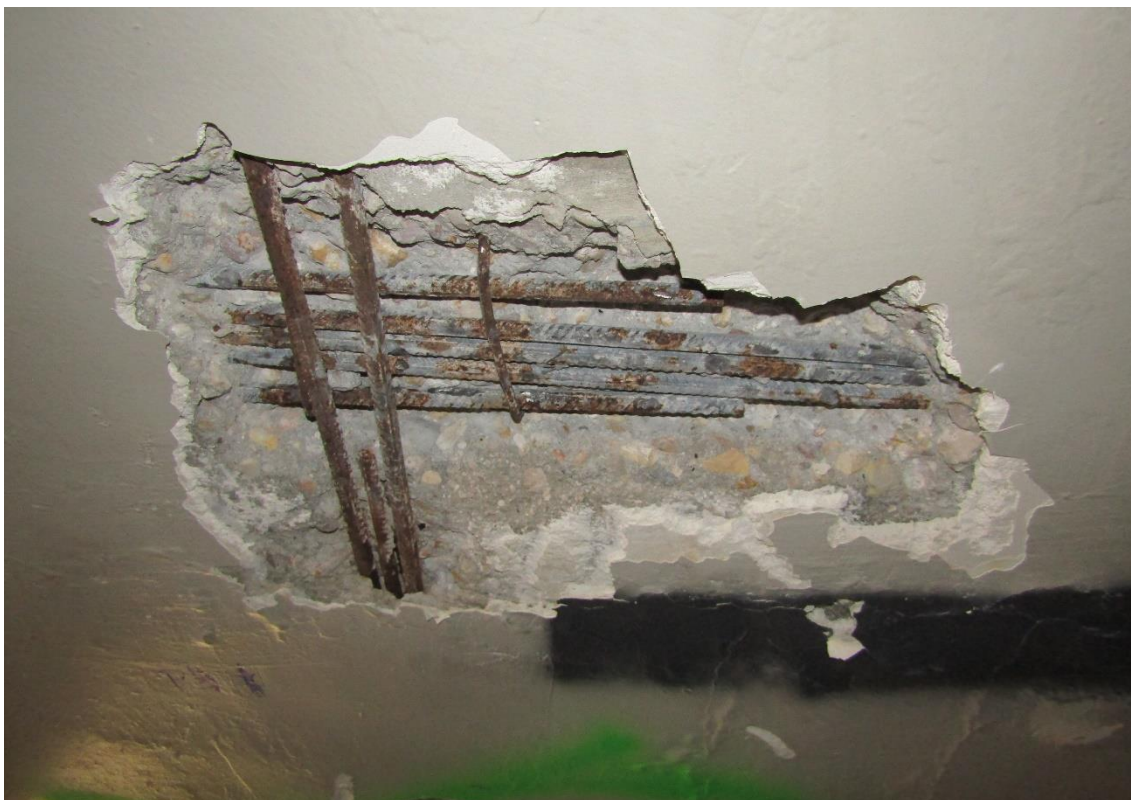
Figura 2-38 Cata P4-1. Acero con pérdida de corruga puntual.
