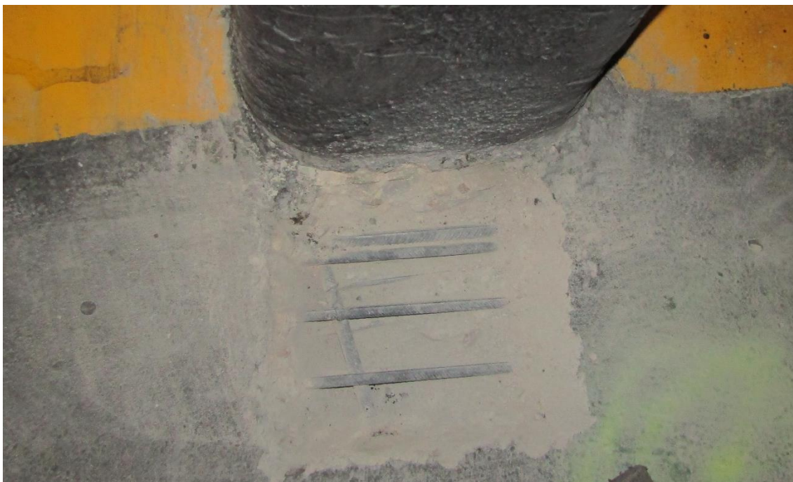
Figura 2-52 Cata P4-12, ejecutada en la cara superior del techo del sótano -4. No signos de corrosión evidente.
