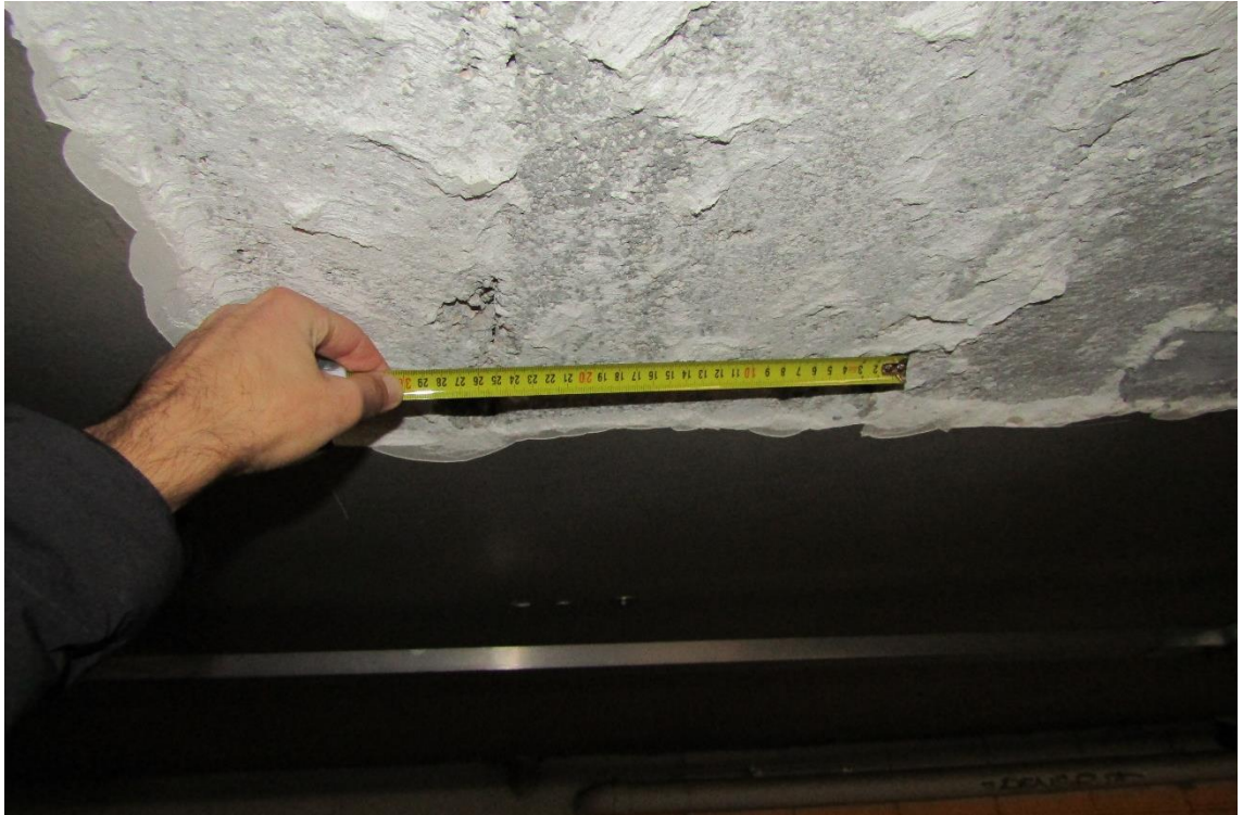
Figura 2-56 Medición ancho casetones, techo del sótano -2.
