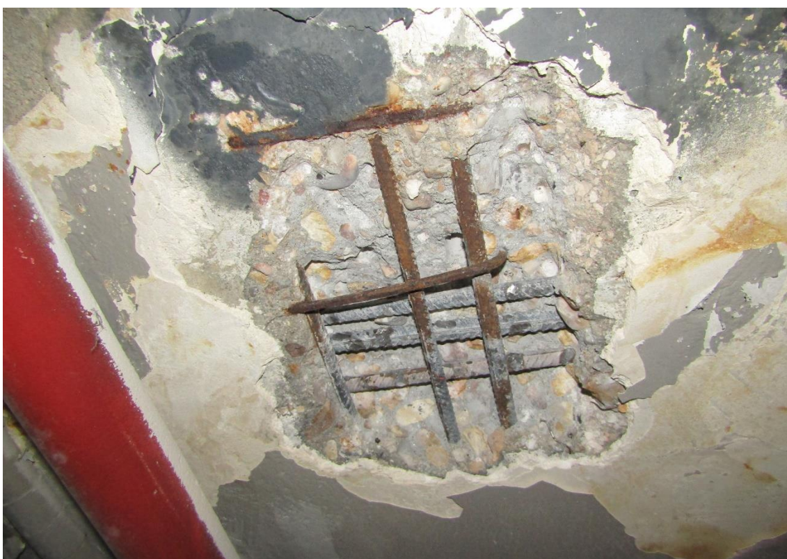
Figura 2-30 Cata P3-4. Acero con pérdida de corruga puntual.
