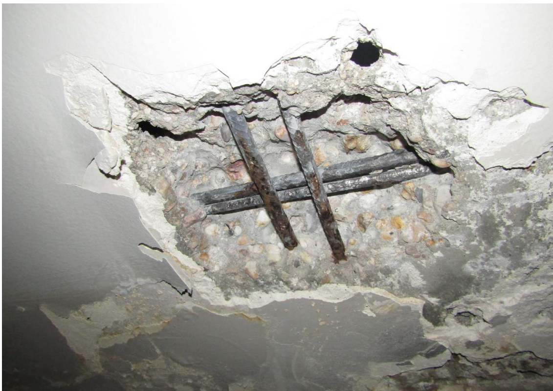
Figura 2-44 Cata P4-6. Acero con pérdida de corruga puntual.
