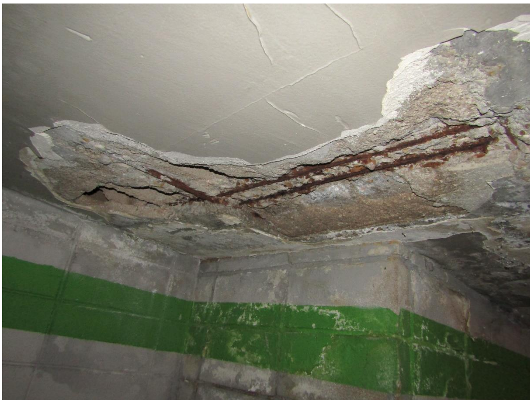
Figura 1-3 Ejemplo paño de forjado de sótano -3 con alto nivel de humedad percibida.
