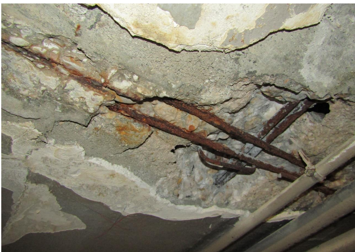
Figura 2-21 Cata P2-6. Acero con pérdida de corruga y pérdida de sección.
