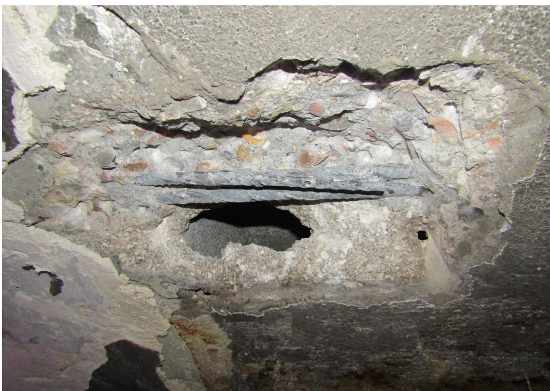
Figura 2-19 Cata P2-4. Acero sin pérdida de corruga. Signos de humedad en el hormigón alrededor de la cata.
