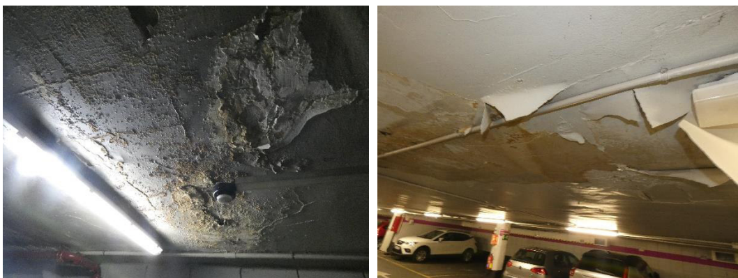
Figura 1-11. burbujas visibles en la cubierta de pintura (izquierda) y pintura que se está pelando (derecha)
