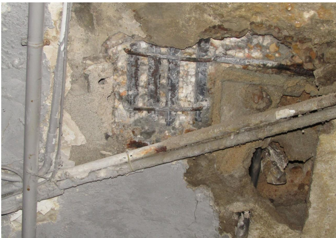
Figura 2-11 Cata P1-10. Acero sin pérdida de corruga. Signos de humedad en el hormigón alrededor de la cata.
