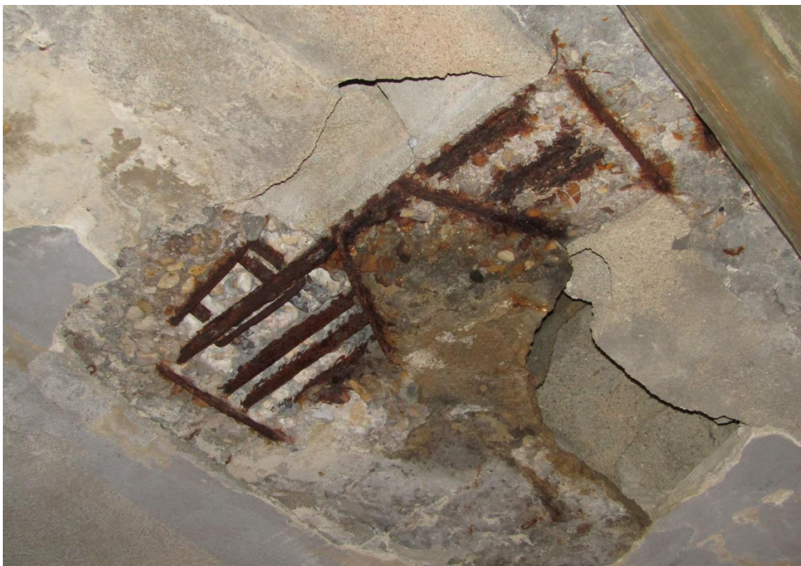
Figura 2-8 Cata P1-7. Acero con pérdida de corruga y pérdida de sección.
