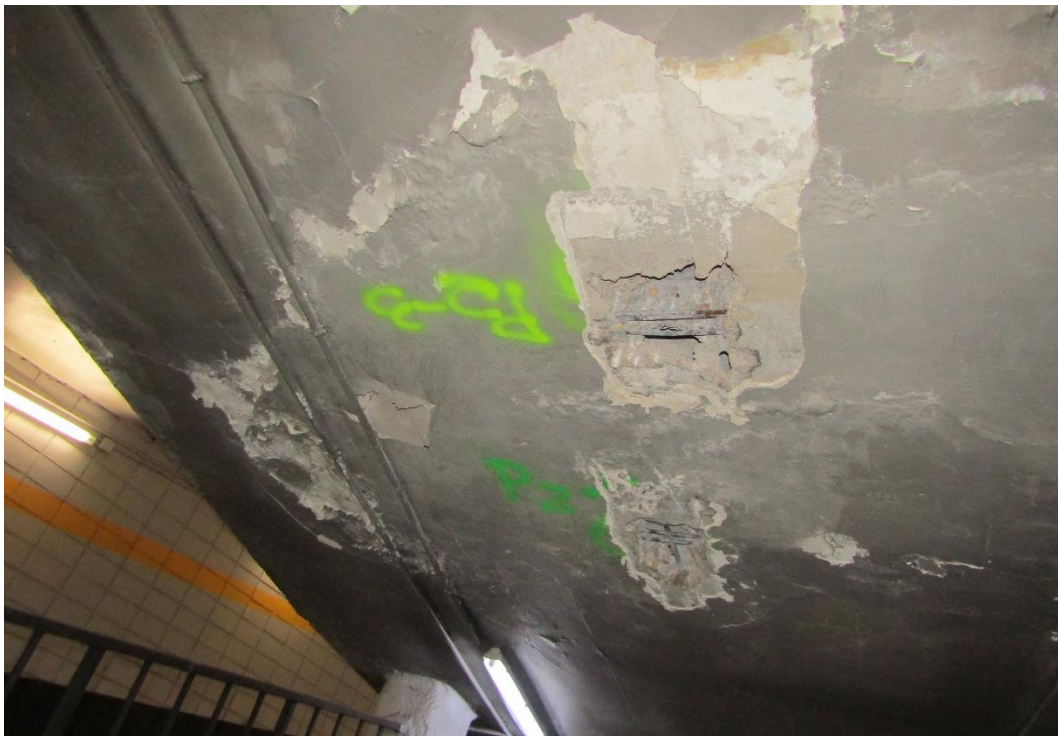
Figura 1-8 Daños en la rampa de subida desde el sótano -2 al sótano -1.
